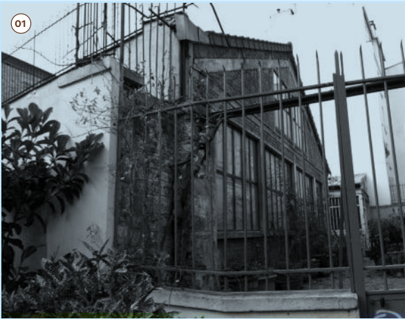
01 Vue sur les verrières et structures de l'ancien atelier bordant la parcelle. Cet héritage bâti de faible hauteur et largement végétalisé témoigne du passé artisanal et faubourien du sous-secteur. 02 Ambiance de la voie piétonne caractérisée par une superposition d'échelles variées (maisons individuelles, petits collectifs, ateliers) et une végétation abondante en bordure de rue. 03 Perspective depuis la Rue de l'Ermitage marquant l'articulation entre le gabarit dense de la rue et l'échelle de la villa
