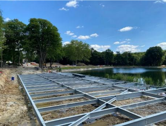
Les deux structures, sur pieux, ne font pas obstacle aux écoulements d'eau dans le sol.
