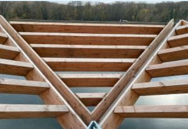
Au niveau des brise-soleil, la charpente bois et la charpente métallique s'imbriquent et sont moisées l'une dans l'autre pour permettre à la structure de s'effiler vers l'eau.
