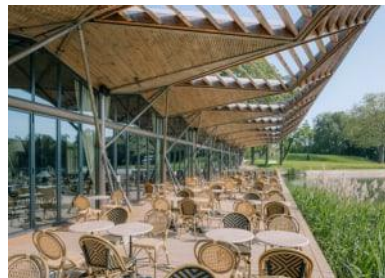
Restaurant du Hangar Y Meudon (92) Livré en 2023
