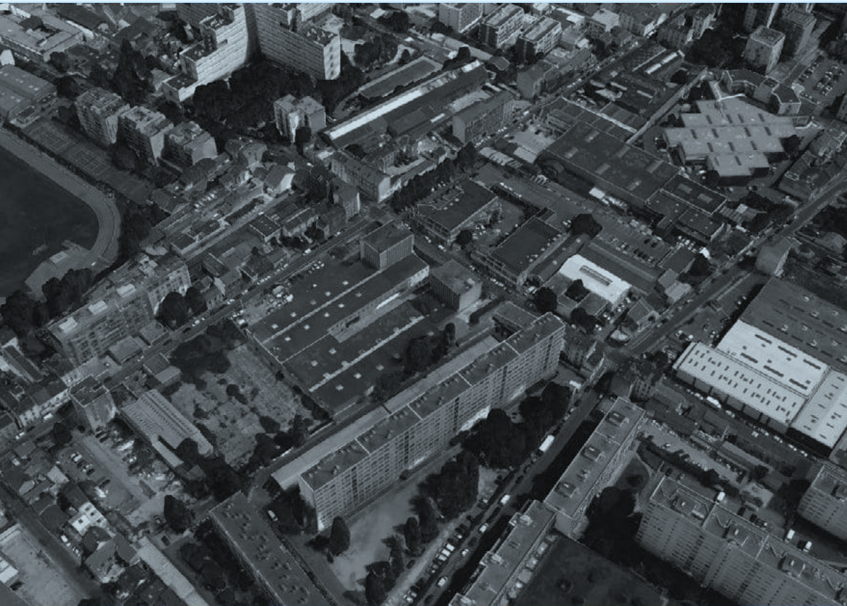
Vue aérienne du secteur Carnot, à Aubervilliers
