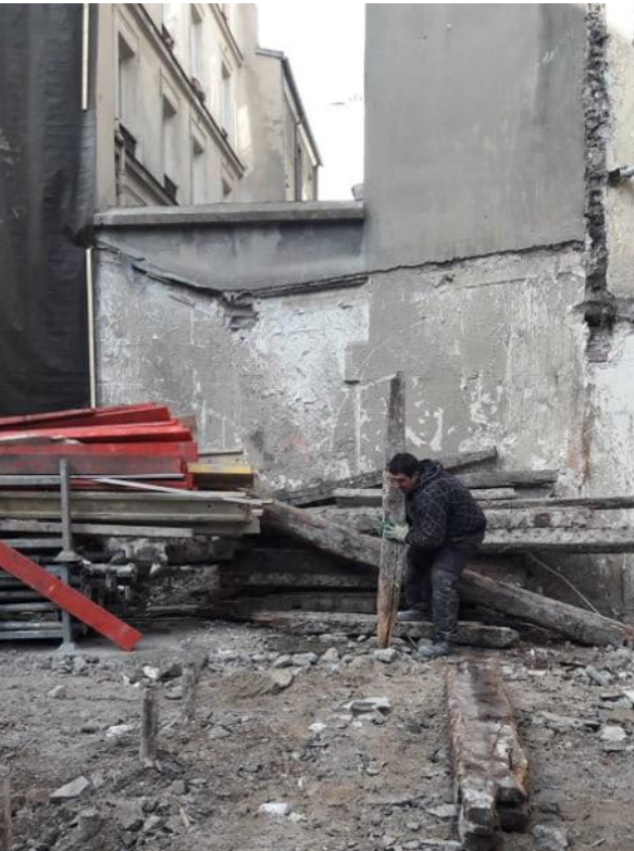
Récupération de poutres rue Godefroy-Cavaignac, à Paris (ci-dessus). Réusiné, ce bois très marqué reprend un bel aspect (ci-contre).
