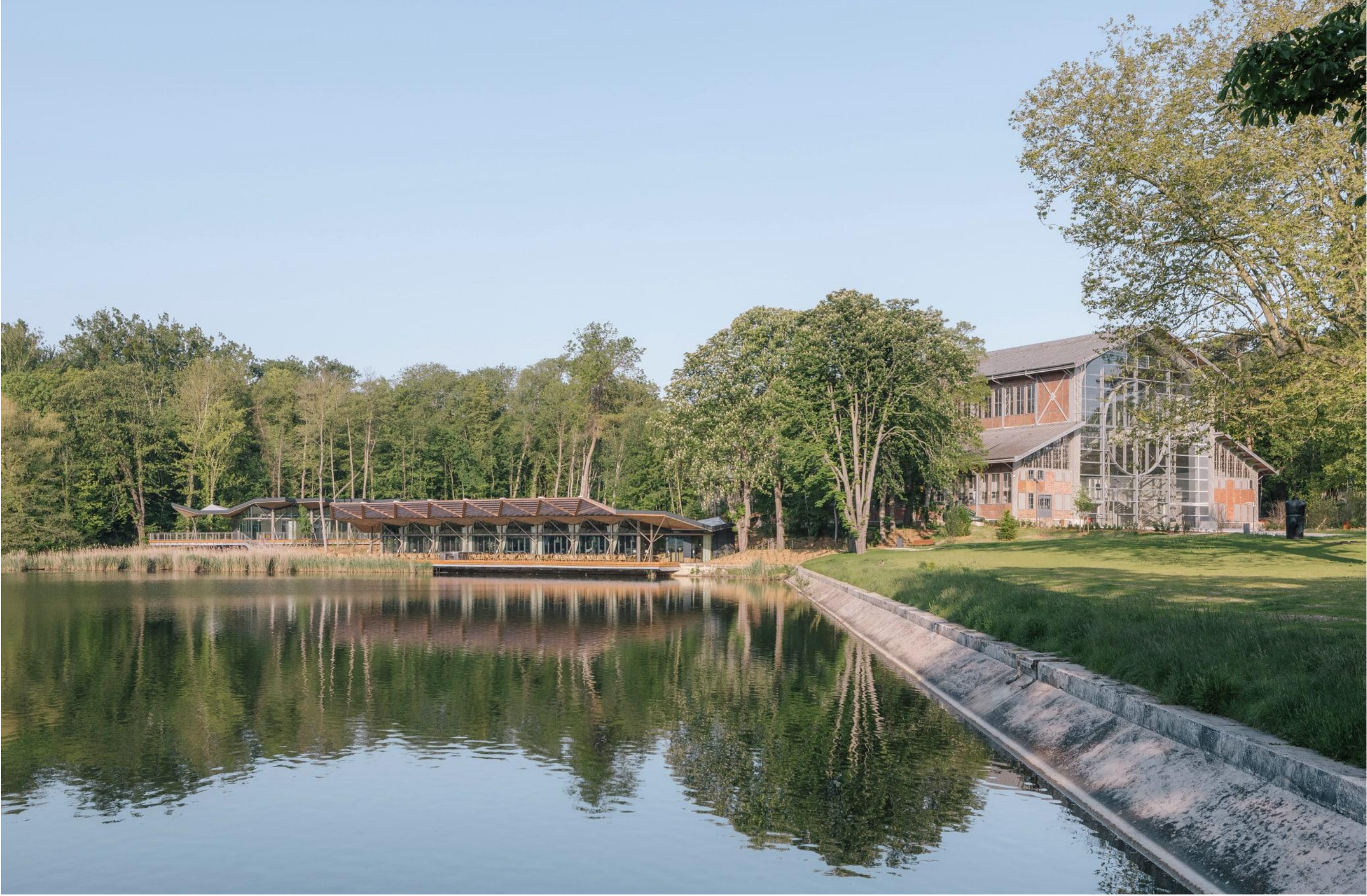
Si les structures métalliques des deux pavillons les inscrivent dans la filiation de l'architecture de De Dion, leur dessin regarde vers un autre horizon : celui du bio-mimétisme.
