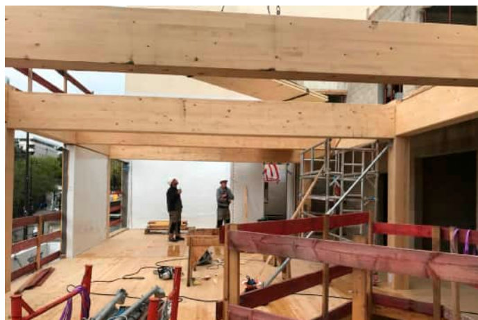
La structure du bâtiment est très majoritairement en bois.
