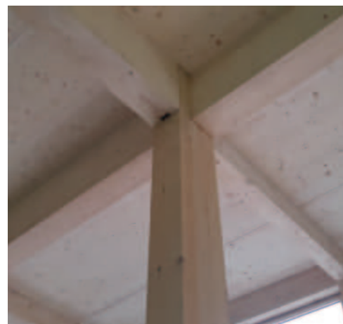
L'énergie la plus vertueuse sera toujours celle qu'on ne dépensera pas. Sur ce bâtiment, 5,6 tonnes de faux plafonds ont été évités: une belle économie!
