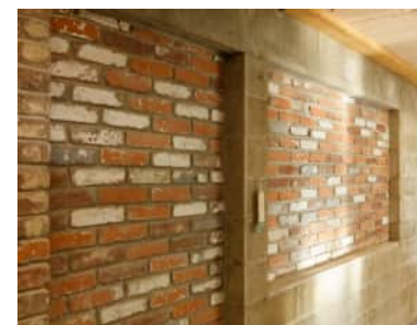
Récupérées, les briques ne peuvent plus être employées structurellement. Nettoyées, elles sont ici réutilisées en second œuvre pour les cloisonnements intérieurs du bâtiment.
