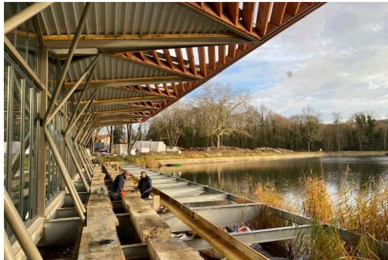
Les dalles de rives, aux mensurations remarquables (120 cm de long, 60 cm de large, 30 cm d'épaisseur) témoignent de l'héritage de Le Nôtre. Elles sont nettoyées et réparées. Au niveau du restaurant, les berges sont complètement refaites: en 300 ans, les arbres y avaient pris racine et les avaient éboulées.
