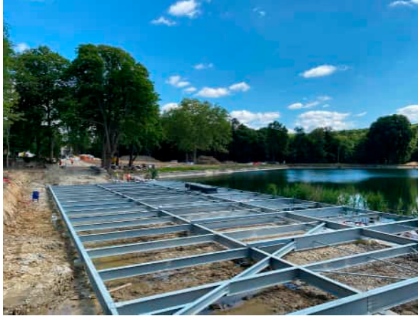
Les deux structures, sur pieux, ne font pas obstacle aux écoulements d'eau dans le sol.
