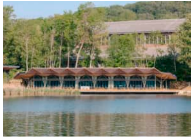
Pavillons et guinguettes du Hangar Y Meudon (92) Livré en 2023
