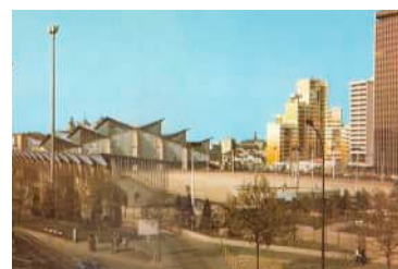
Ilot 27 Pantin (93) 2023- en cours
