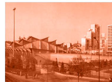
Ilot 27 Pantin (93) 2024-en cours
