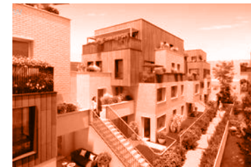
Villa Favory Aubervilliers Carnot Du sol au ciel, rendre sa place à la nature et donner l'élan d'une mutation vertueuse
