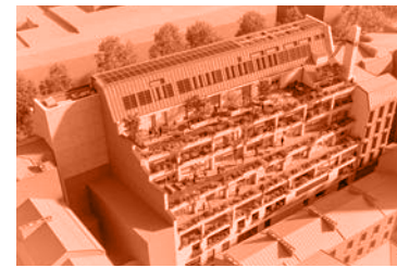
Siège de la SCI 55 Réhabilitation énergétique d'un immeuble de bureaux
