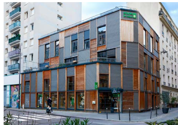
Le labo d'Envie prend place sur un terrain d'angle entre deux bâtiments où était situé un vieux garage.
