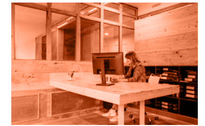
École du Renouveau Urbain Construire l'identité d'un lieu de travail autour d'une cloison de 42 m en réemploi
