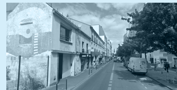
Vue depuis la rue du Pré-Saint-Gervais : des façades dégradées
