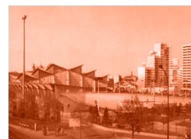
Ilot 27 Pantin (93) 2024-en cours
